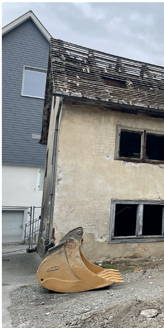
Ortsbild schützt von Abbruch nicht! Abbruch und Verdichtung im Nationalen Ortsbild Altdorf. (Foto: Pietro A. Caviglia 2024)
